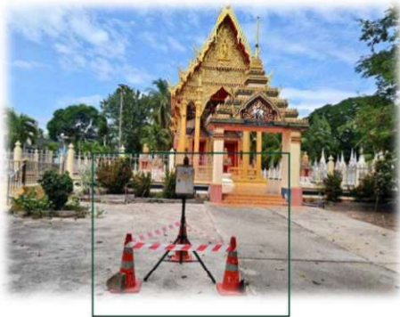
งานเสริมทรายเพื่อป้องกันการกัดเซาะ บริเวณชายหาดชะอำ
